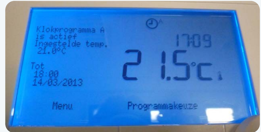
Modulerende kamerthermostaat
