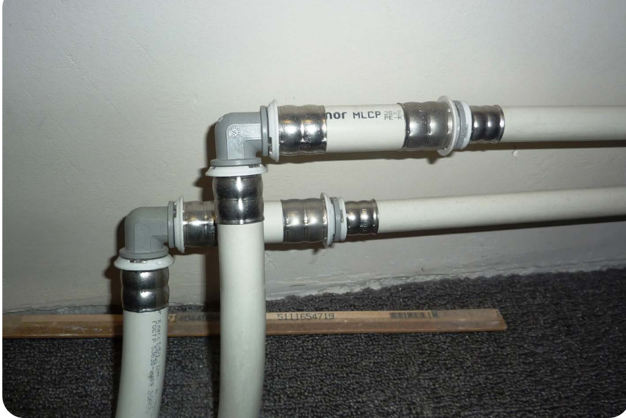
Koppelingen in een kunststof leidingsysteem
